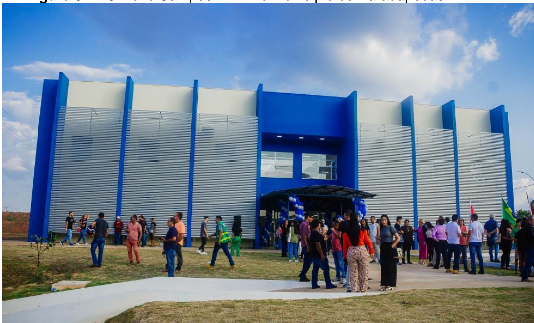
Figura 91 – O Novo Campus XXIII no município de Parauapebas
