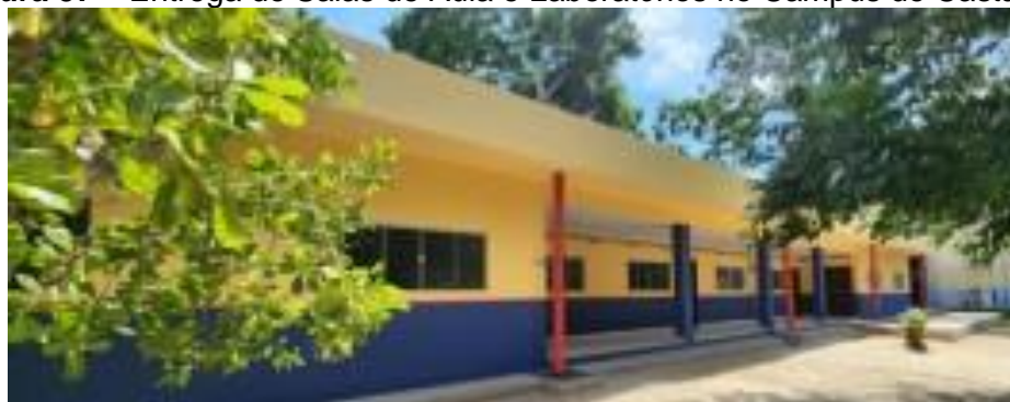
Figura 57 – Entrega de Salas de Aula e Laboratórios no Campus de Castanhal
